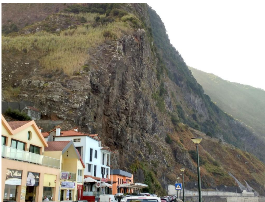
Figura 1.1. En los archipiélagos de la Macaronesia, se pueden observar con cierta frecuencia taludes con pendientes subverticales (Isla de Madeira).
