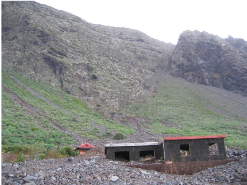
Figura 2.7. Coladas de derrubios o "debris flow" producidas en depósitos coluviales tras las intensas lluvias acaecidas en la isla de El Hierro en noviembre de 2004.
