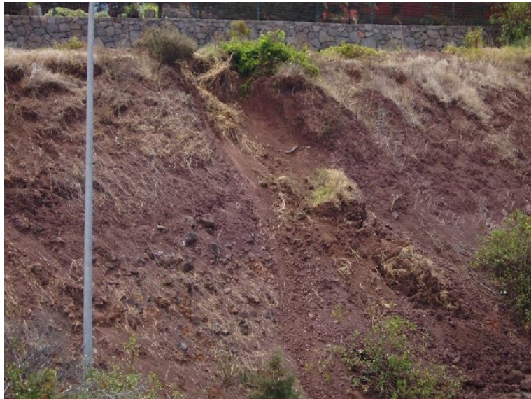
Figura 2.6. Deslizamiento traslacional de piroclastos sobre basaltos alterados (Isla de Gran Canaria, Canarias).
