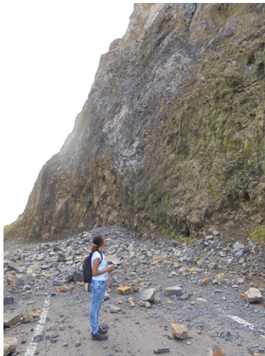
Figura 2.2. Desprendimientos rocosos en talud de carretera con corte de la circulación, (Cabo Verde).
