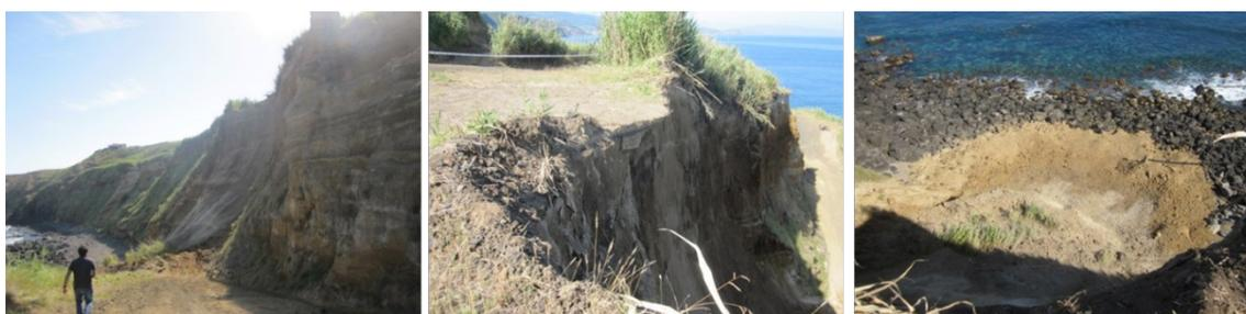
**Figura 3.9** Ejemplo de un deslizamiento. A la izquierda, la ladera inestable, en el centro la retirada del material en coronación y a la derecha la propagación, en el pie de los materiales movilizados.
