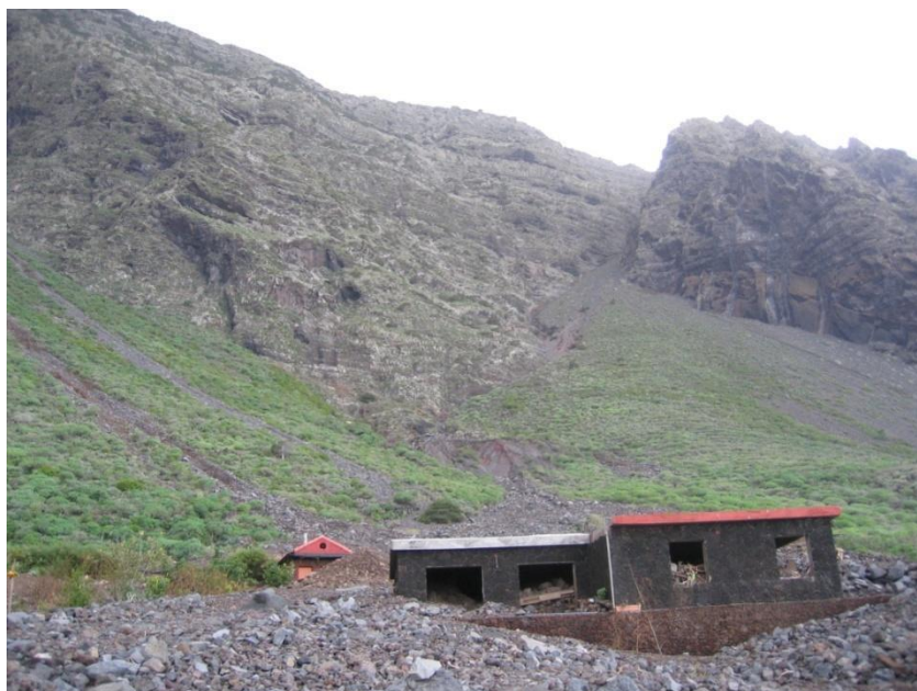
Figura 2.7. Escoadas detríticas ou “debris flow” causadas em depósitos coluvionares pelas fortes chuvas que ocorreram na Ilha de El Hierro em novembro de 2004.
