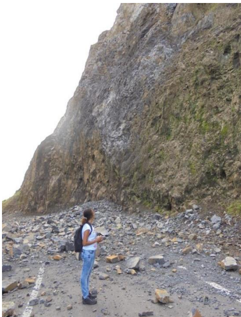
Figura 2.2. Queda de blocos rochosos num talude de estrada, com corte de circulação (Santiago, Cabo Verde).
