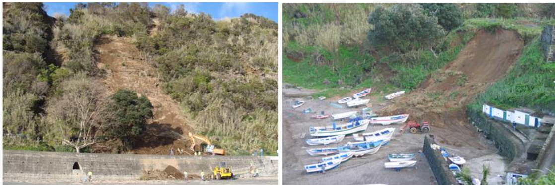
Figura 3.4. Deslizamentos translacionais superficiais em taludes de depósitos de piroclastos pomíticos.
