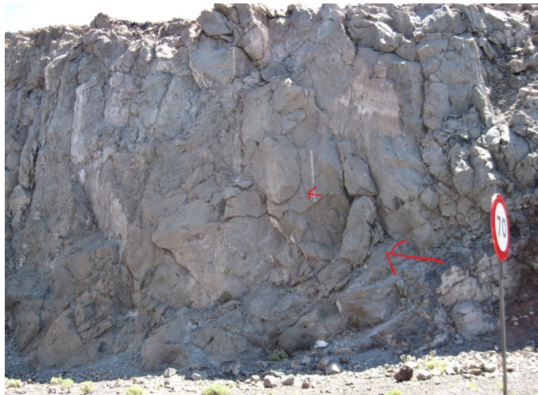
Figura II.6. Colada traquítica con pendiente muy elevada en la que los bloques tienen una orientación que favorece el desprendimiento por descalce.
