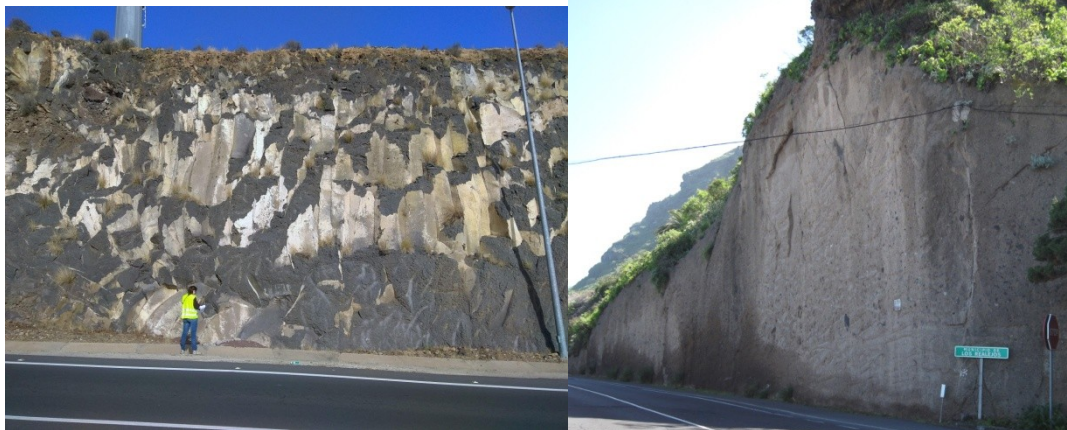
Figura II.2. Ejemplos de macizos tipo A. A la izquierda macizo basáltico y a la derecha talud en piroclastos sálicos.
