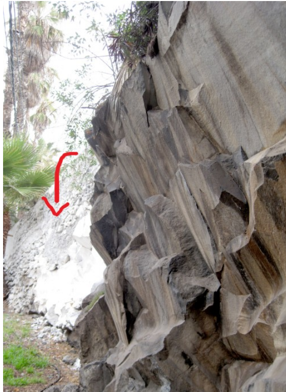
Figura II.5. Ejemplo de talud en el que los planos de discontinuidad y la inclinación de la estructura, generan bloques cuya orientación favorece el desprendimiento por vuelco.
