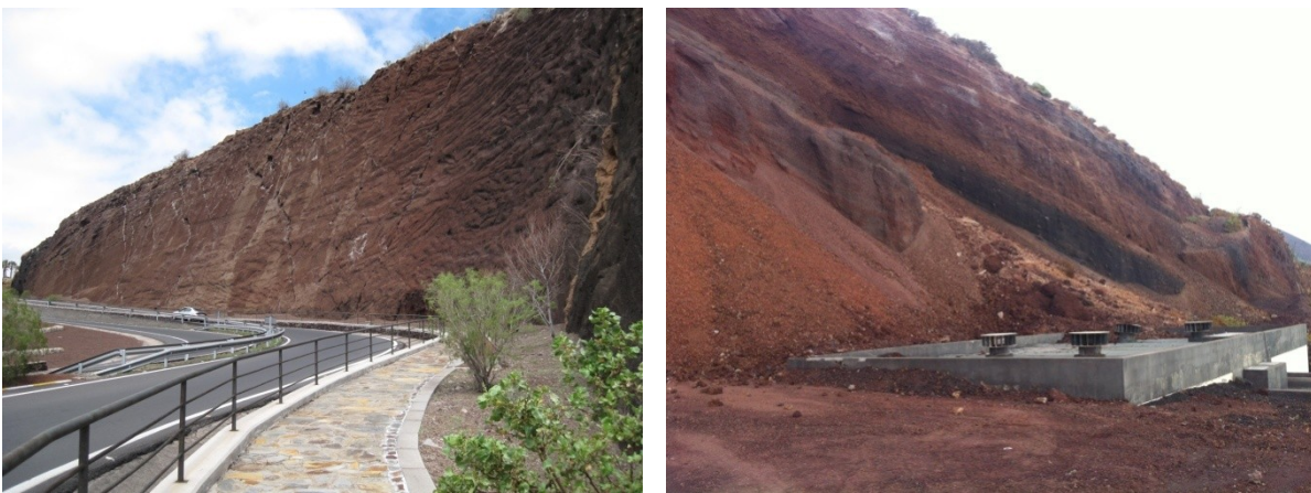
Figura II.7. Ejemplos de macizos tipo B con distinto grado de soldamiento, a la izquierda con cierto grado de cohesión, y a la derecha piroclastos sueltos.
