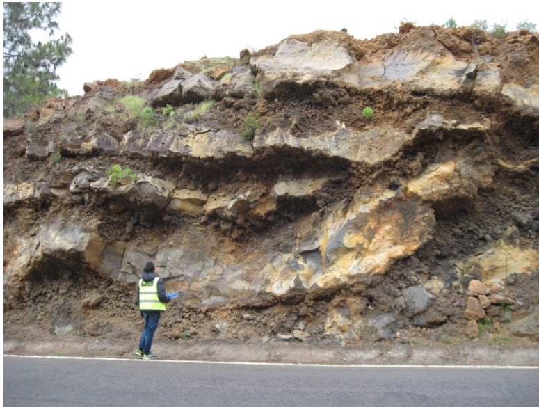
Figura II.11. Ejemplo de talud con erosión diferencial y formación de cornisas. Se observa que la erosión del material más blando ha dejado los bloques de
