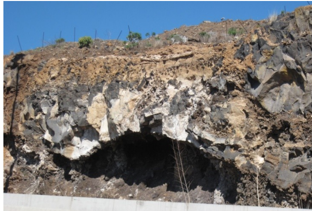
Figura II.9. Ejemplos de macizos tipo C. A la izquierda se observa la alternancia de materiales y a la derecha formación de cornisas en el talud.
