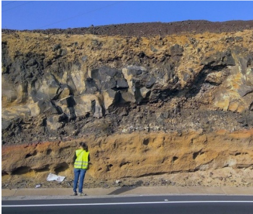
Figura II.9. Ejemplos de macizos tipo C. A la izquierda se observa la alternancia de materiales y a la derecha formación de cornisas en el talud.
