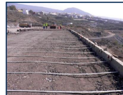
Figura VII.1.7 - Muro de gabiões (esquerda) e muro de terra armada em construção (direita).
