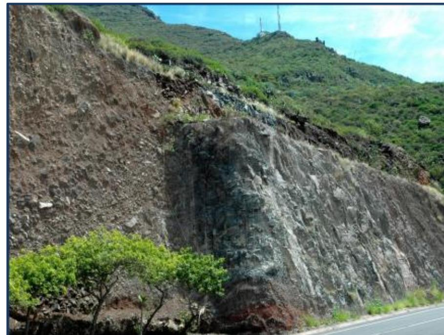
Figura VII.1.3 - Talude com banqueta.
