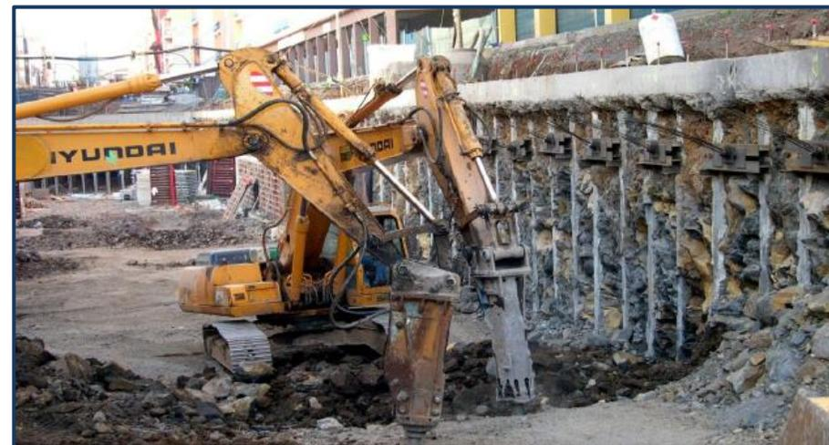
Figura VII.1.8 – Microestacas.
