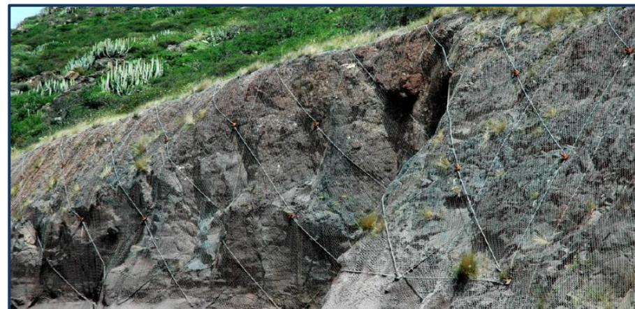
Figura VII.2.5 – Sistema misto de cabos e malha.
