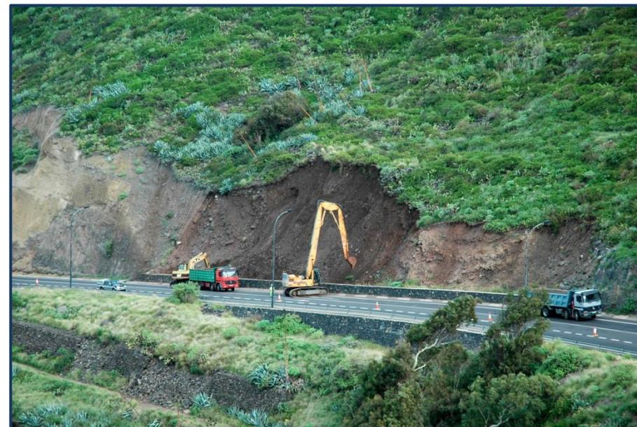
Figura VII.1.1 - Reperfilamento por escavação.
