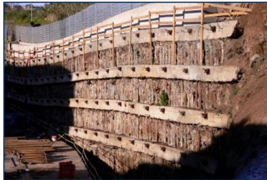
Figura VII.1.6 – Ancoragens unidas através de uma viga de betão
