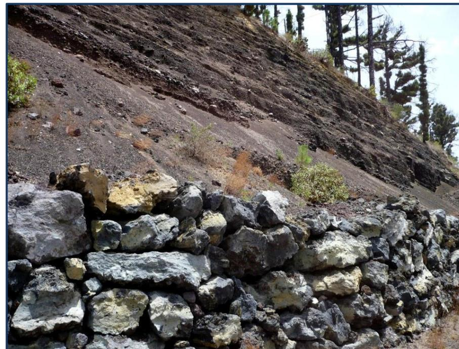
Figura VII.1.2 - Reforço do pé do talude.
