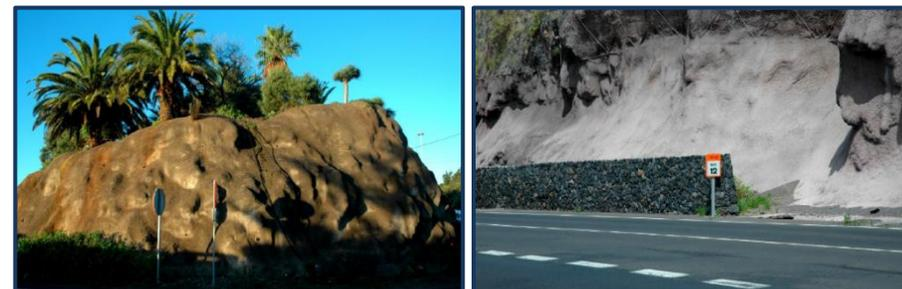
Figura VII.2.6 - Betão projetado com pigmentos (esquerda) e betão projetado sem coloração (direita).
