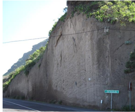
Figura II. 2. Exemplos de maciços do tipo A: à esquerda um maciço basáltico e à direita um talude de piroclastos soldados (ignimbrito soldado).
