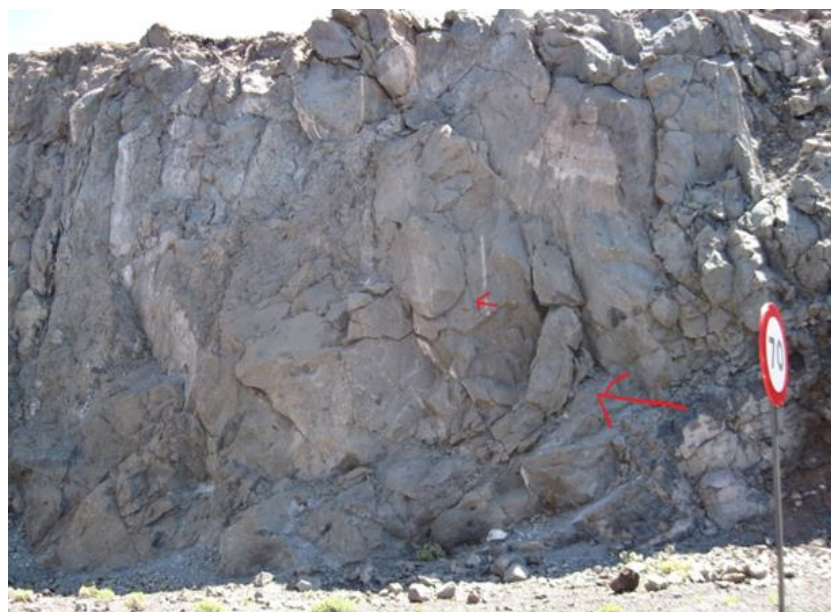
Figura II. 6. Escoda traquítica com declive muito elevado onde os blocos têm uma orientação que favorece o desprendimento por descalçamento.
