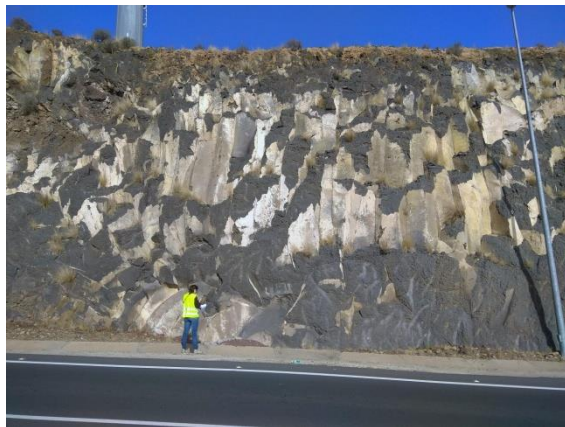
Figura II. 2. Exemplos de maciços do tipo A: à esquerda um maciço basáltico e à direita um talude de piroclastos soldados (ignimbrito soldado).
