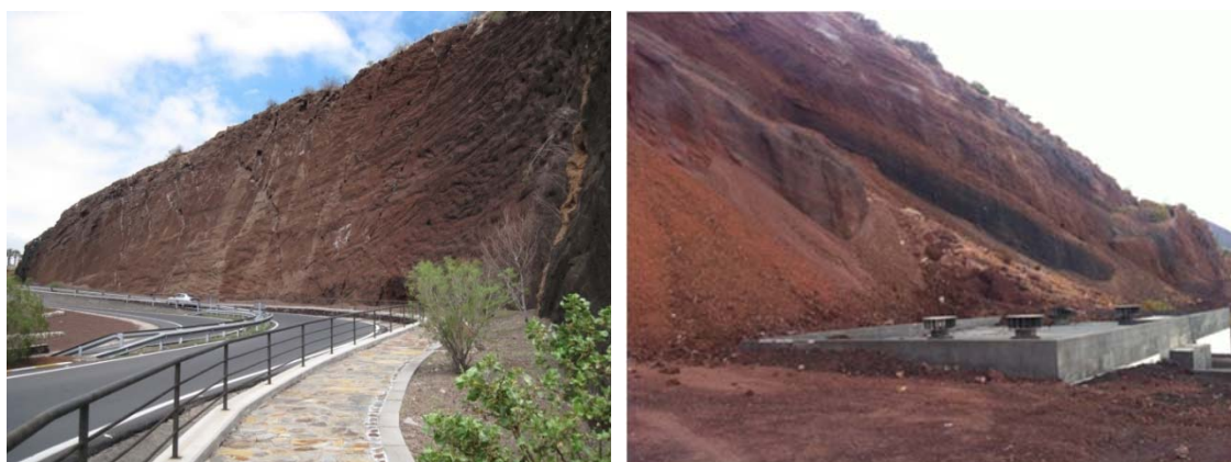
Figura II. 7. Exemplos de maciços do tipo B com graus de imbricamento e soldagem distintos: à esquerda piroclastos com um certo grau de soldagem e, à direita, piroclastos soltos.
