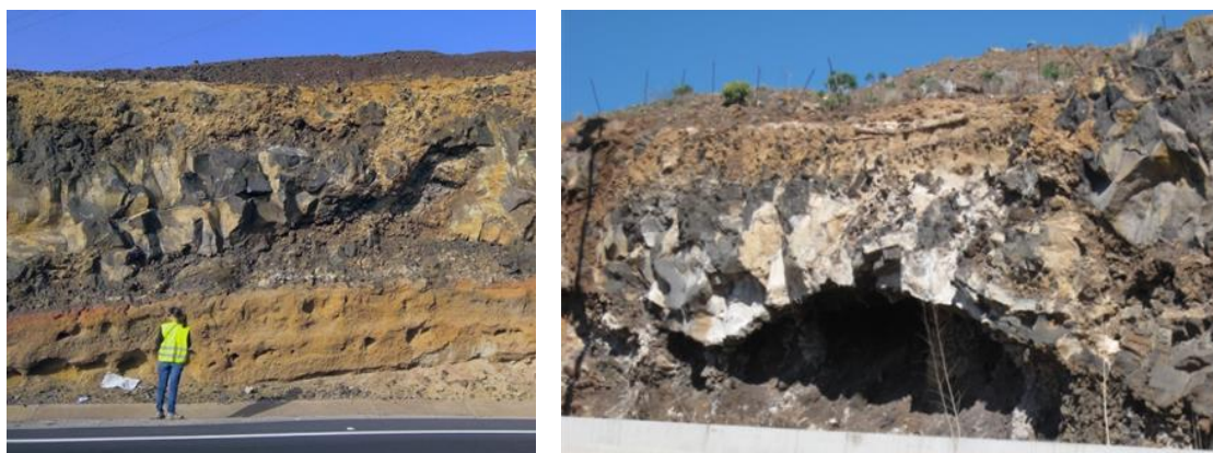
Figura II. 9. Exemplos de maciços do tipo C: à esquerda observa-se a alternância entre materiais distintos, e à direita a formação de cornijas.
