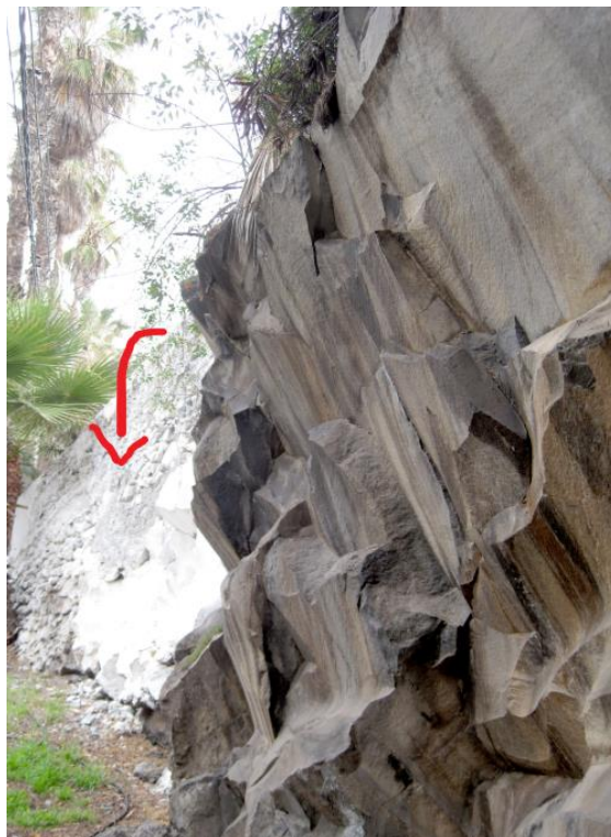
Figura II. 5. Exemplo de um talude em que os planos de descontinuidades e a inclinação da estrutura principal originam blocos cuja orientação favorece o desprendimento por basculamento.
