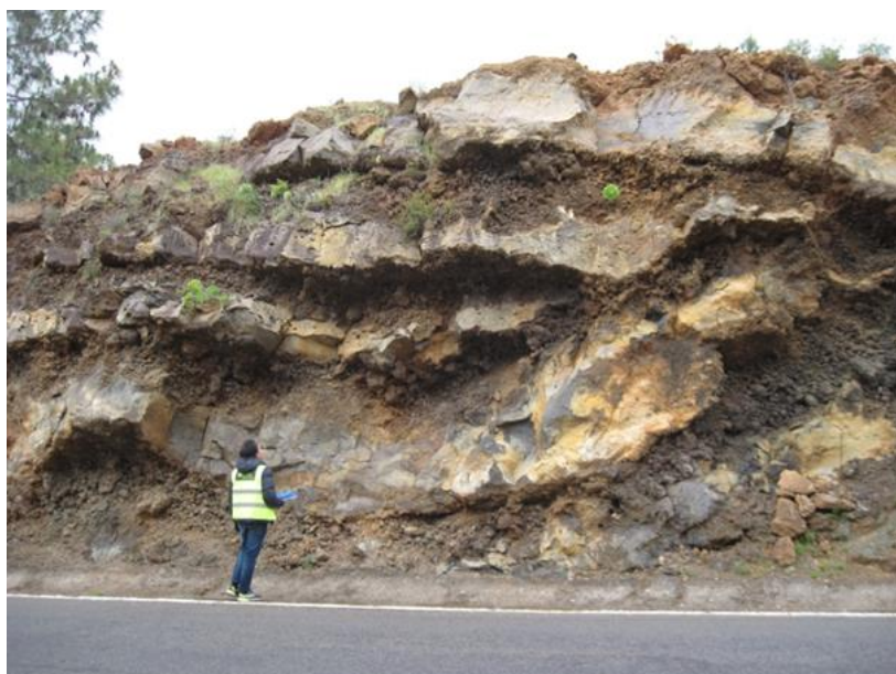
Figura II. 11. Exemplos de talude com erosão diferencial e formação de cornijas. É possível observar que a erosão do material mais brando deixou alguns blocos de rocha em consola.
